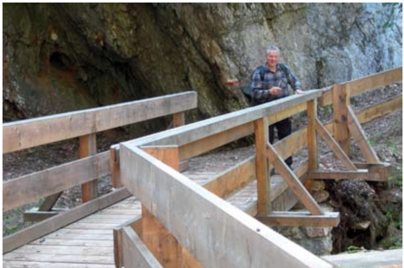
Ripristino di una passerella in legno e parapetti a valle
